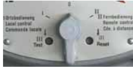
图 M-6: 一体化控制单元上的选位开关
