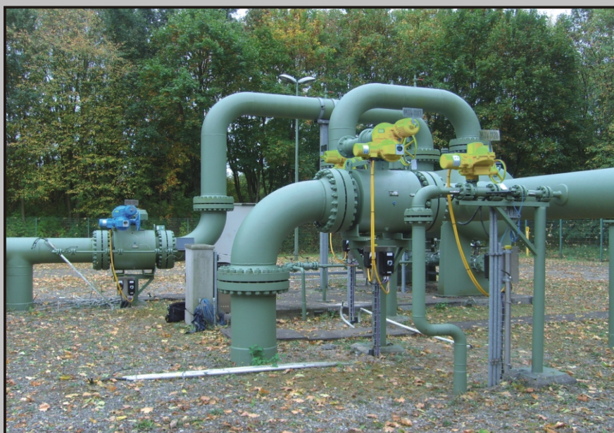
配套球阀的x-matic执行器，典型输气管线应用
